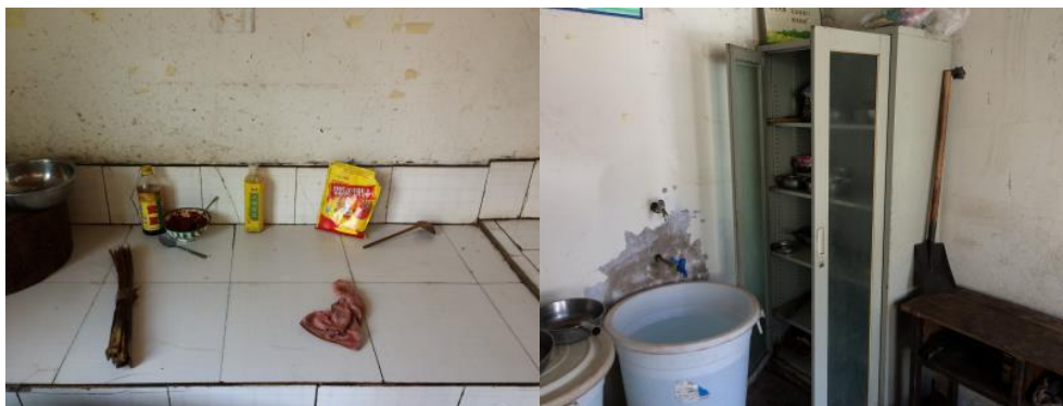
图5 厨房操作间全景及局部
