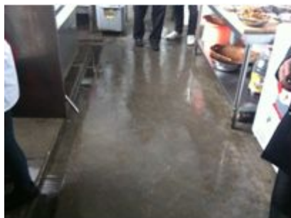
图 6 厨房地面情况图
