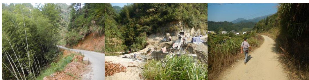
图1 路况组图(距古源村约1公里处,桥被洪水冲毁正在维修中,车辆无法通行)
