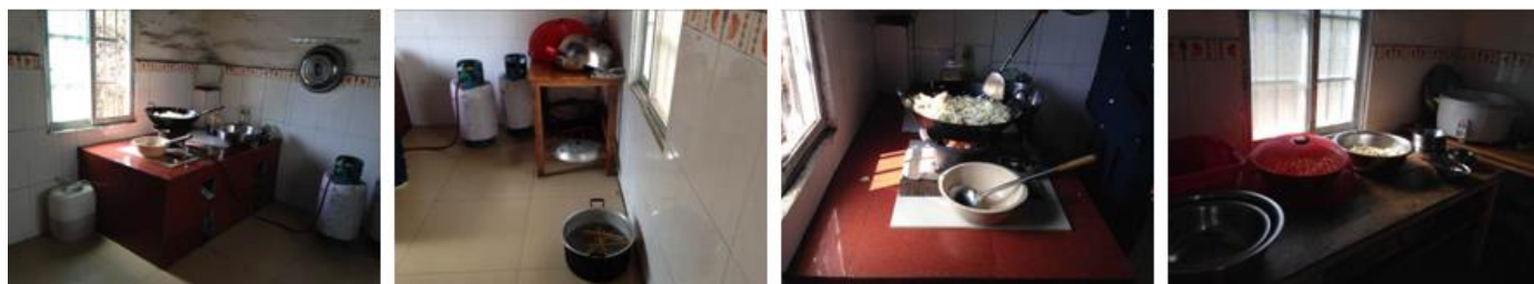
图 6 厨房全景及局部情况
