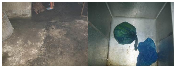
图 16 墙面地面卫生
