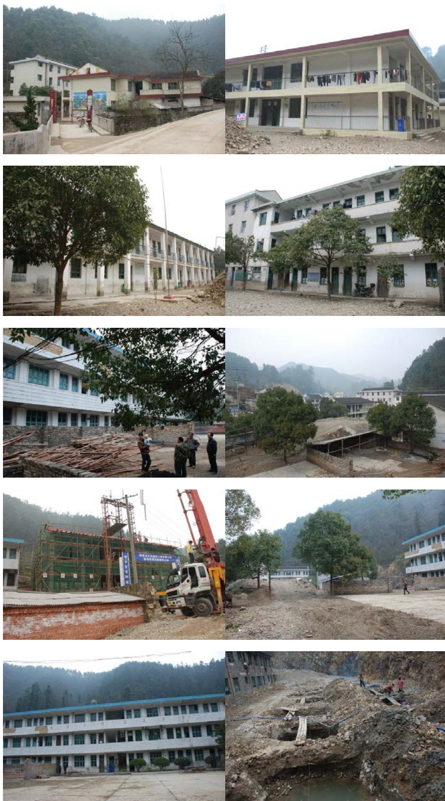
图2 学校组图（学校正在搞基建，就像个大工地）
