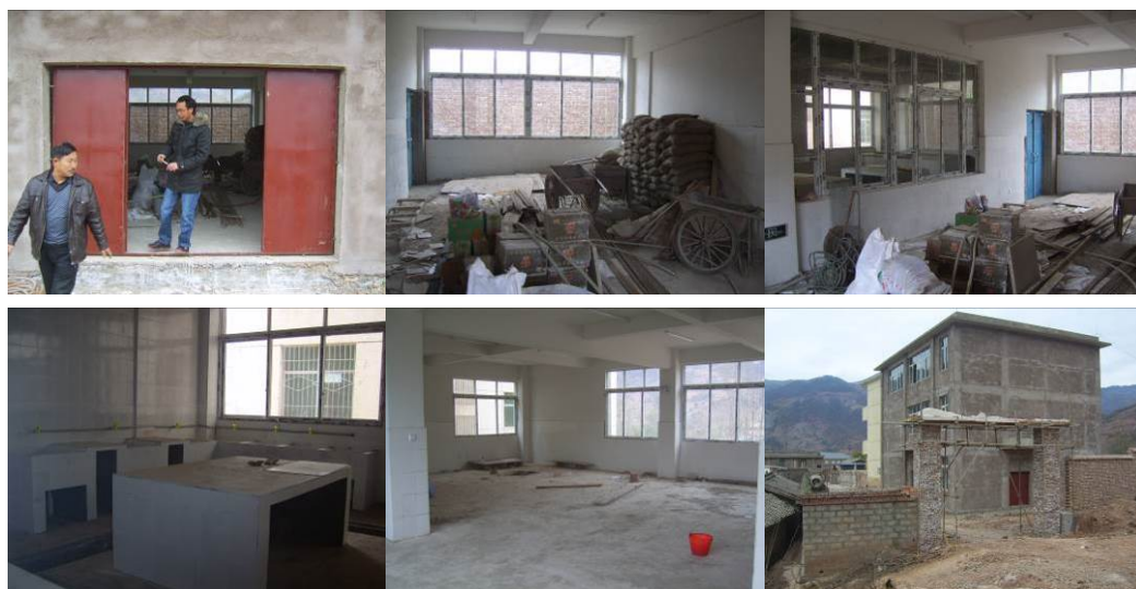
图 4 正在建设中的新厨房和餐厅组图
