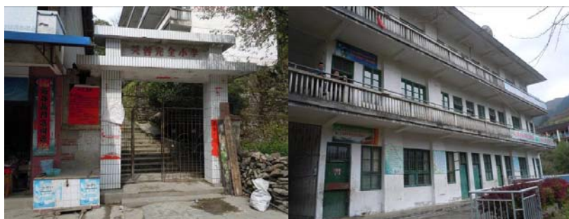
图二 芙蓉小学小学校区大门及教学楼
